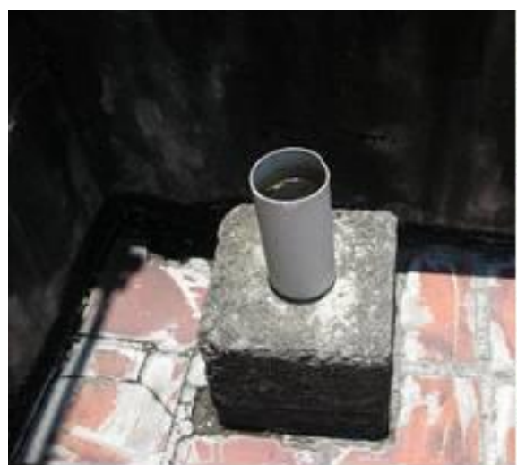
水泥樁上之水管
