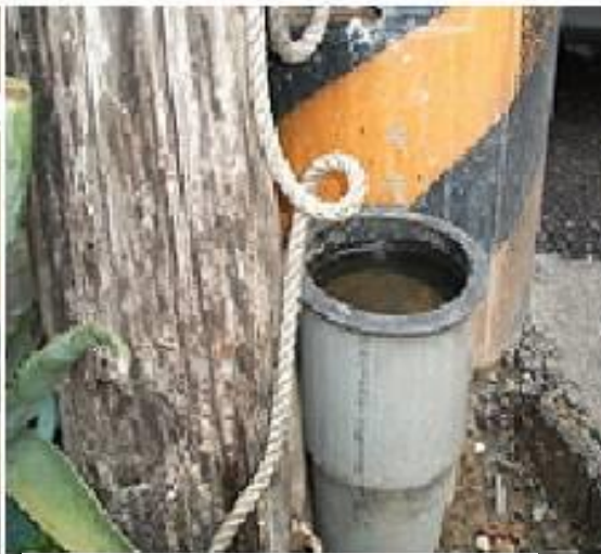
台電地下電纜引上管
