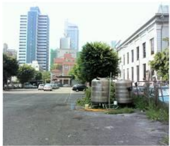
停車廠水塔無蓋
