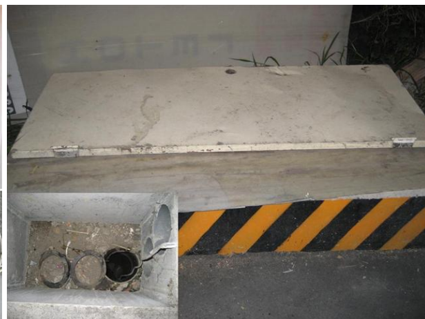
電信電纜管道
